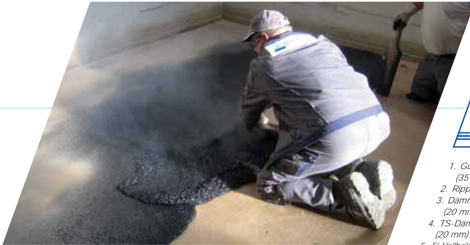
Mit Gussasphaltestrich lassen sich hervorragende Schalldämmwerte erzielen – vorausgesetzt, der Unterbau stimmt!
